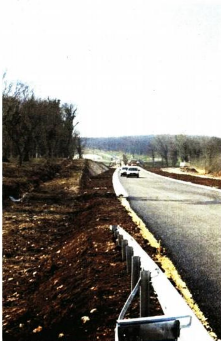
Trenutačno se postavlja završni sloj asfalta
